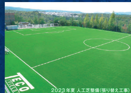
2023年夏 人工芝整備(張り替え工事)
